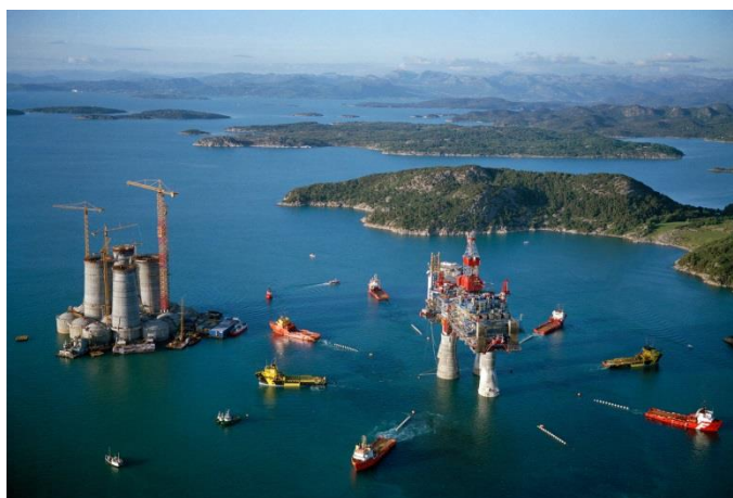
写真1 ストルド市における組立拠点
