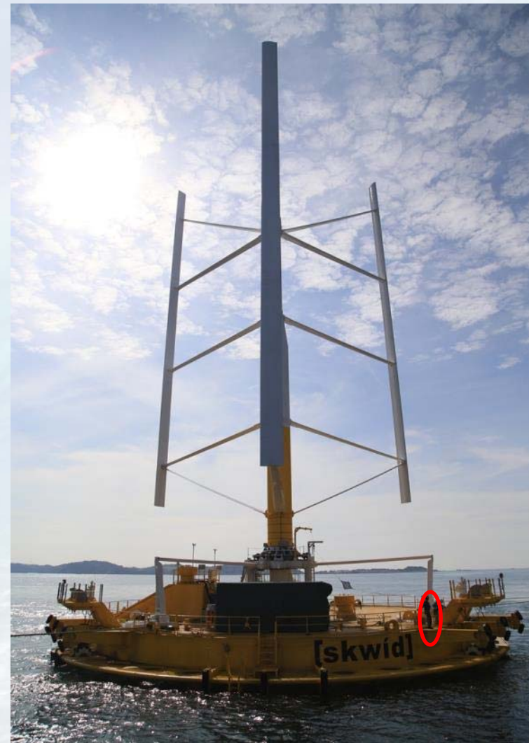
設置工事の様子
