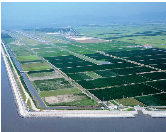
補強された海岸堤防
