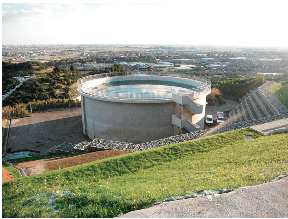
佐賀西部高域揚水機場 (吐水槽)
