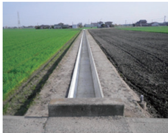
用水路の機能が復旧
