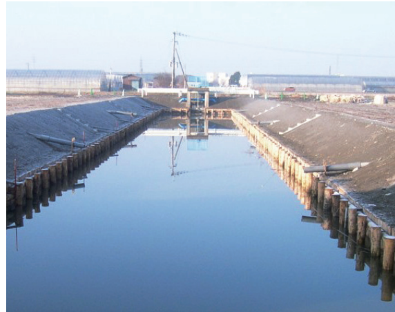
急激な水位変動にも耐える護岸に整備
