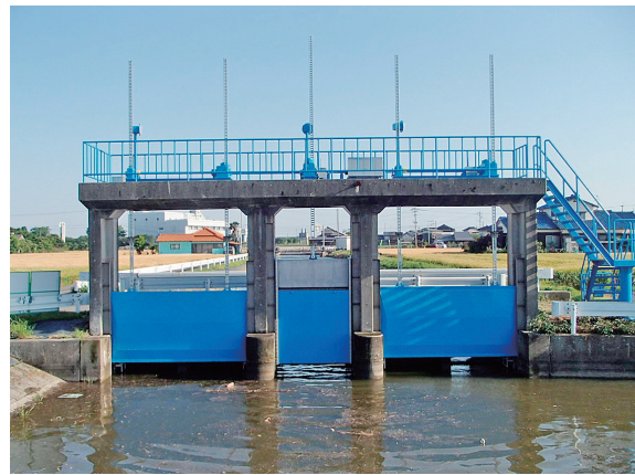
補修後のゲート
