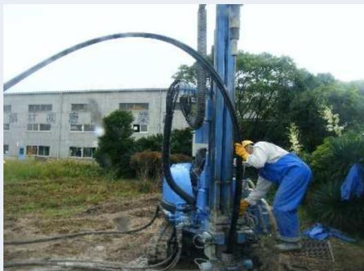
地中熱交換器(Uチューブ)の埋設
