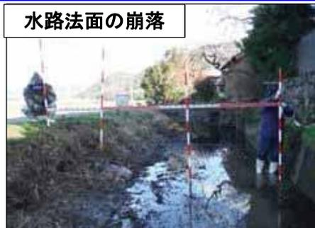
左岸側の水路法面が崩落しており、施設管理に労力を要している
