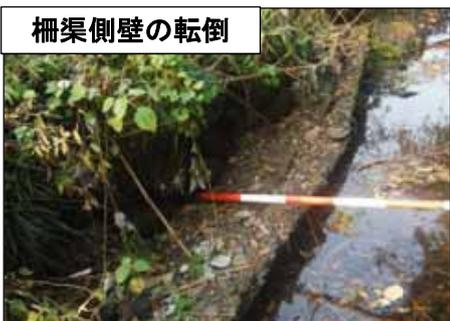
柵渠の側壁が壊れ、水路側に転倒し農業用水の通水を阻害している
