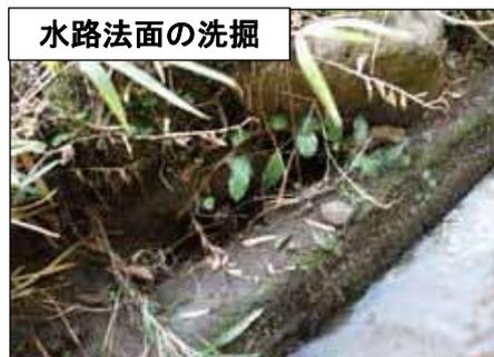
側壁上部の水路法面が洗掘されており、施設管理に労力を要している
