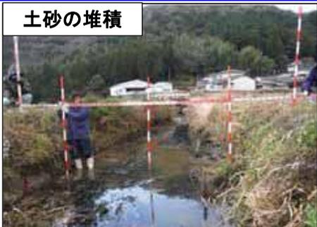
水路内に土砂が堆積し、農業用水の通水を阻害している
