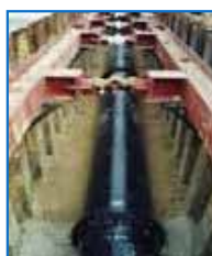
パイプライン施工状況
