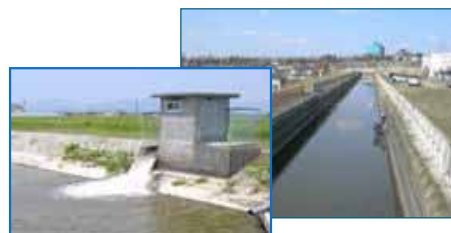
パイプラインからの分水施設
