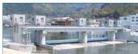
河川からの取水施設 (川上頭首工)
