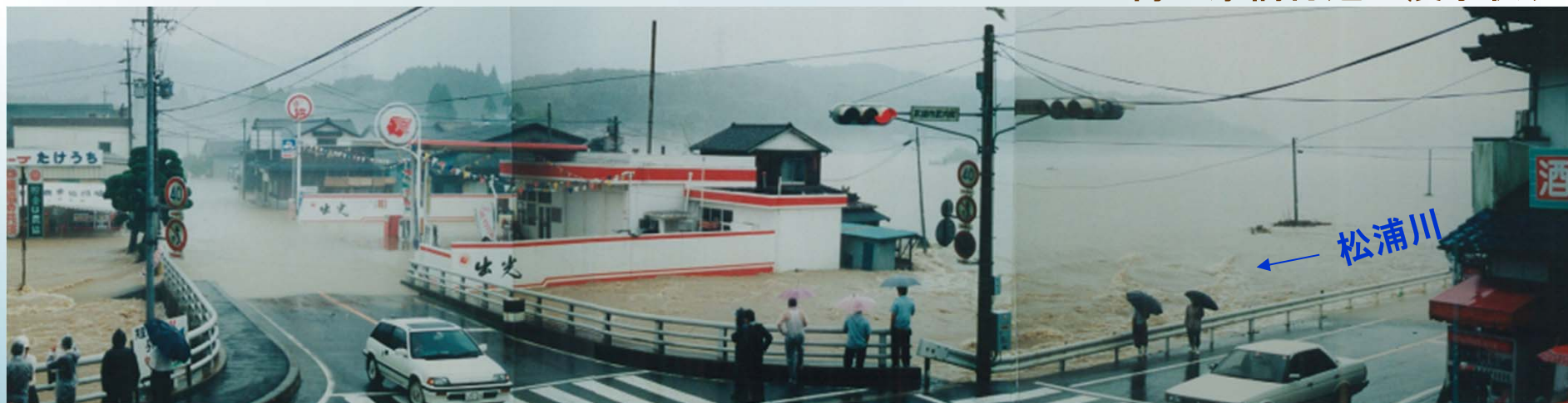
梅の原橋付近の浸水状況
