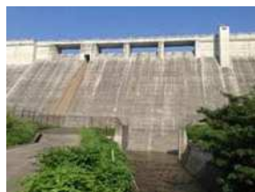
洪水吐き(非常用洪水吐き)
