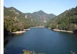
貯水池周辺斜面
