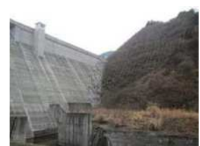
堤体周辺斜面
