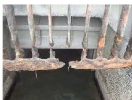
スクリーン腐食及び破断(樋門)
