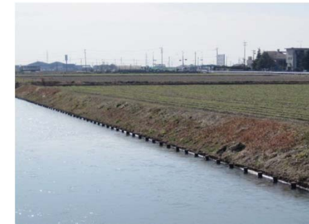
整備された排水路
