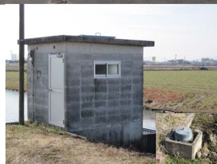
整備された用水施設 （用水ポンプ場、給水栓）
