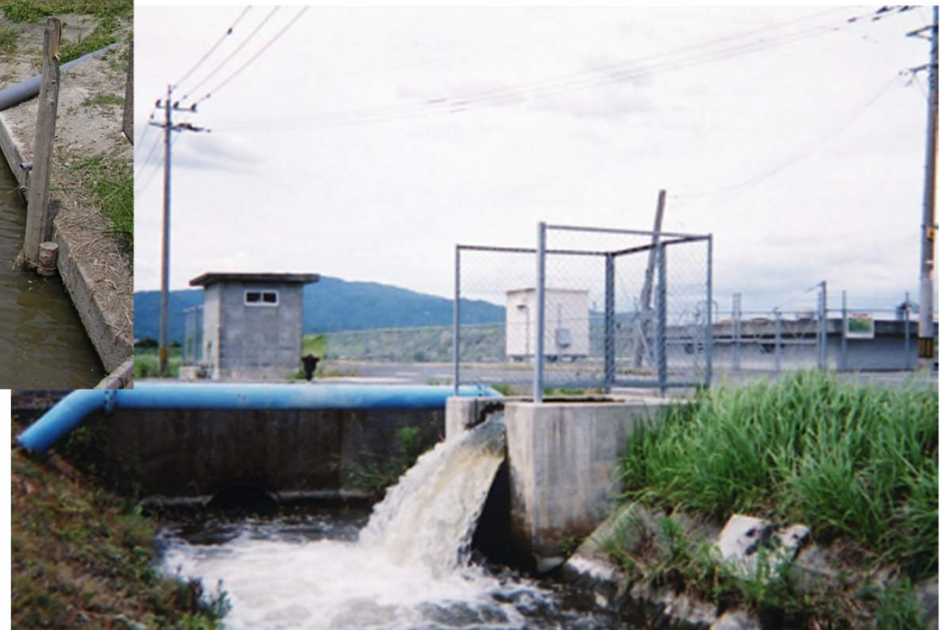
県営中原西部線 分水口の利用状況
