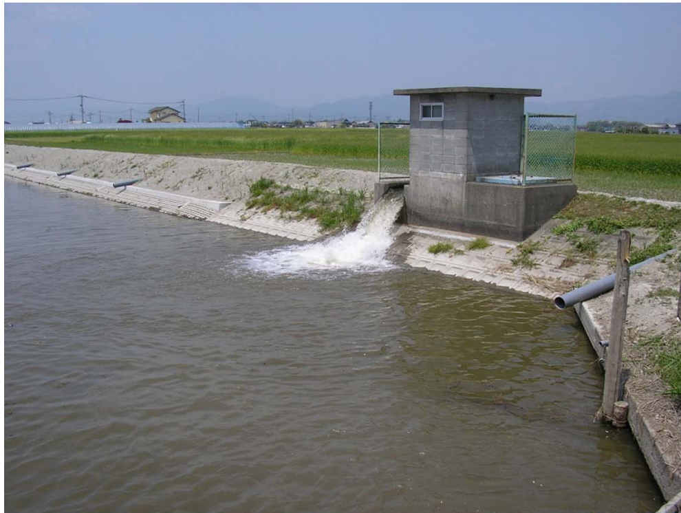
県営六津崎線 分水口の利用状況
