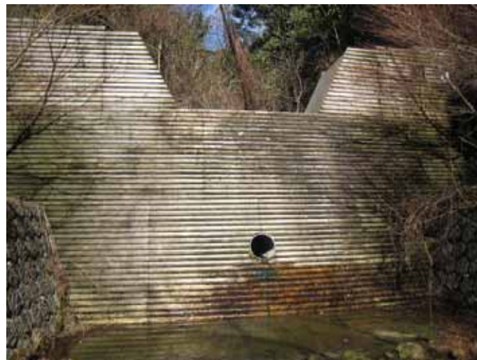
残置式木製型枠
