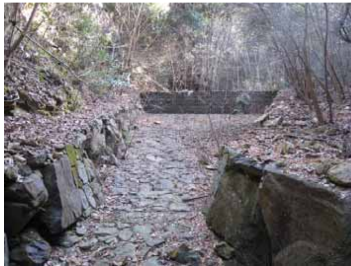
現地発生材を利用した流路工
