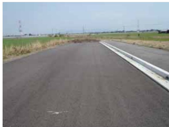
終点側から起点側を望む (終点側改良済み区間)
