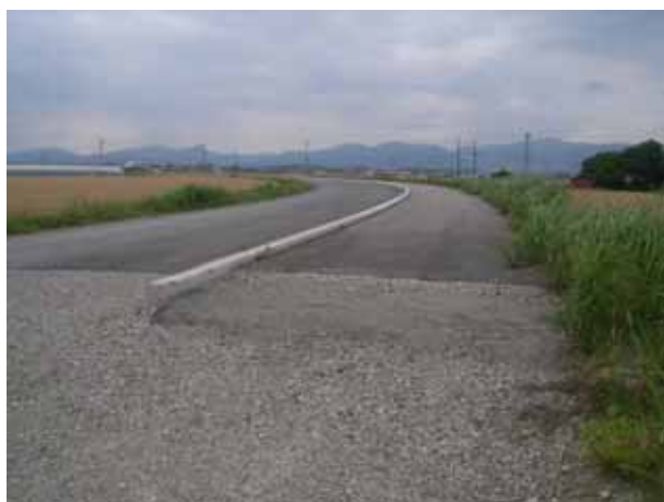
起点側から終点側を望む (起点側改良済み区間)
