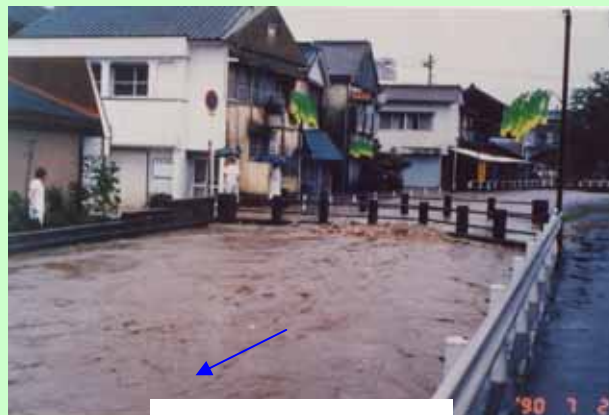
中の橋付近の状況
