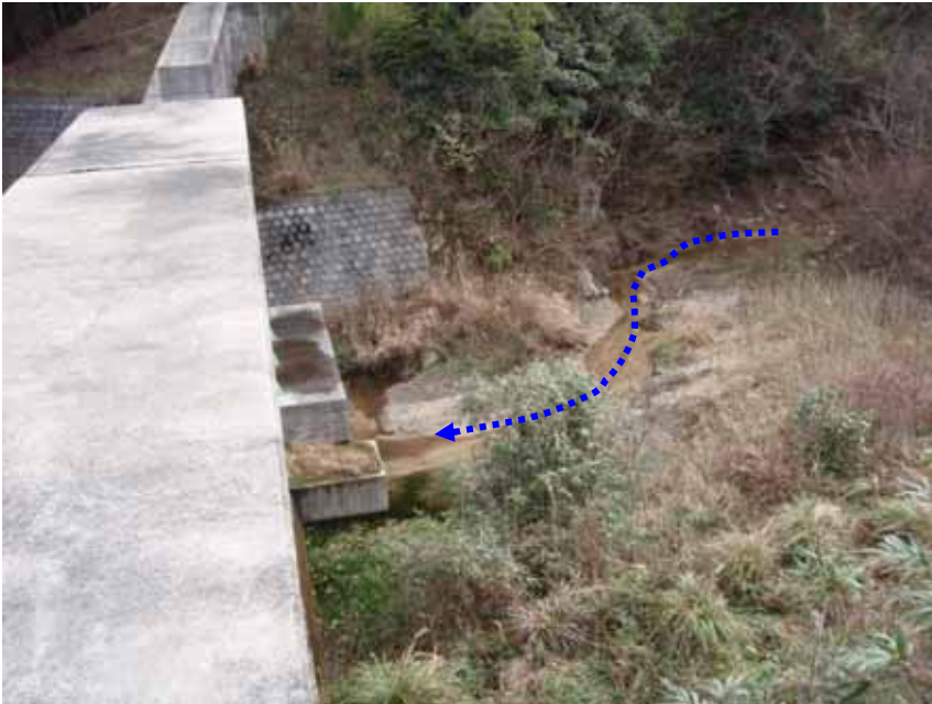
左岸川えん堤袖部より望む
