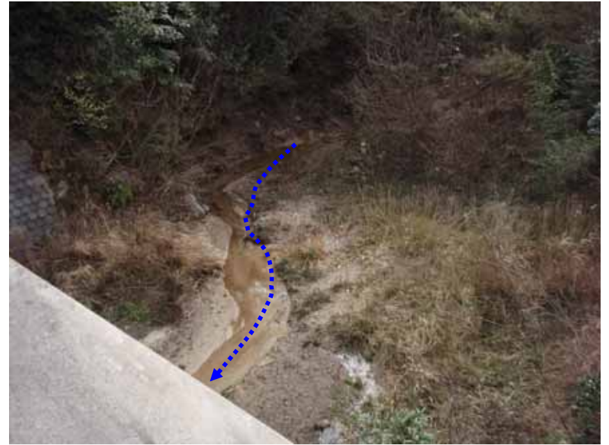
左岸川えん堤天端より望む
