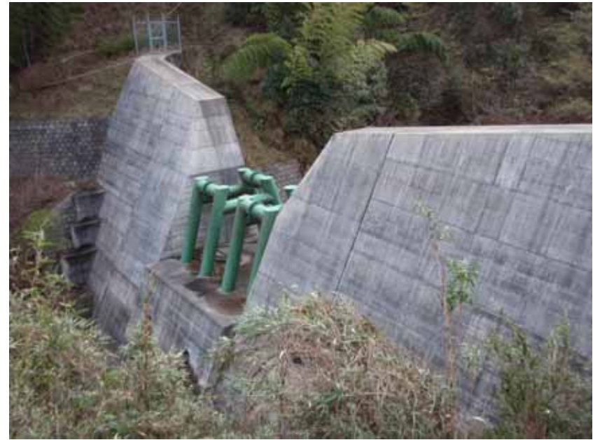
左岸側からえん堤を望む
