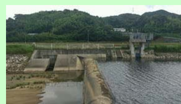
大坪頭首工に魚道を設置
