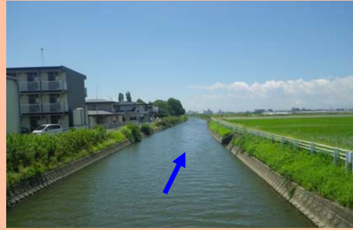
【支川新川 北島橋 (1k120) より下流を望む】
