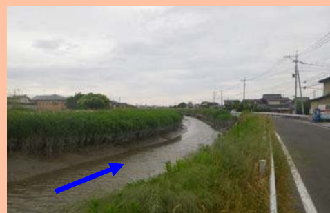
【新高橋4k420右岸付近より下流を望む】
