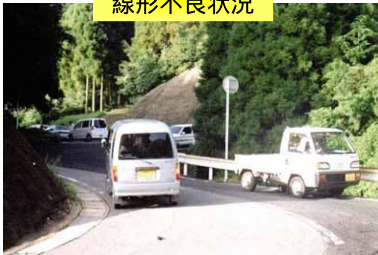
線形不良状況
