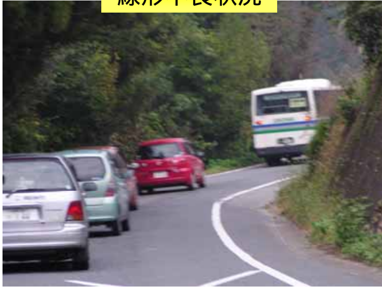
線形不良状況
