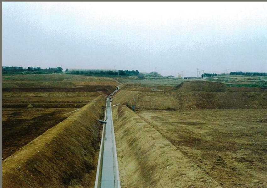
区画整理 (排水路)
