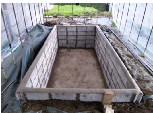
第 19 図 自家施工 7t 級のブロックタンク
