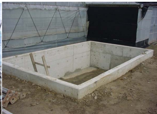
第 20 図 業者施工 20 t 級のタンク
