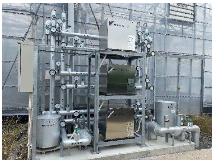
図7 地中熱ヒートポンプ
