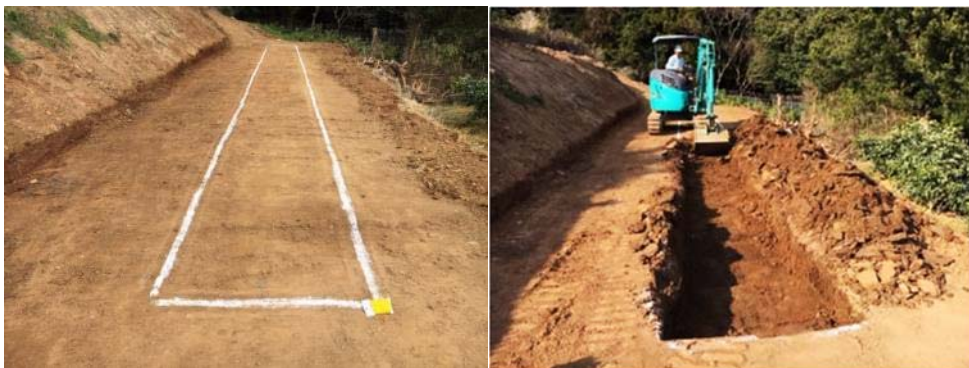
図3 整地と畝部の掘削
