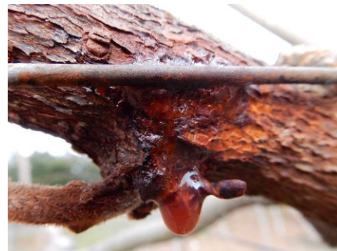
写真3 赤褐色の樹液の漏出
