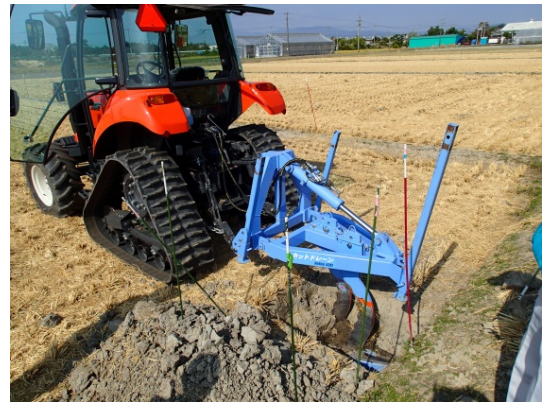
写真2 カットドレーンの施工
