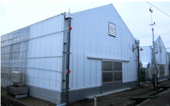
統合環境制御施設の外観
