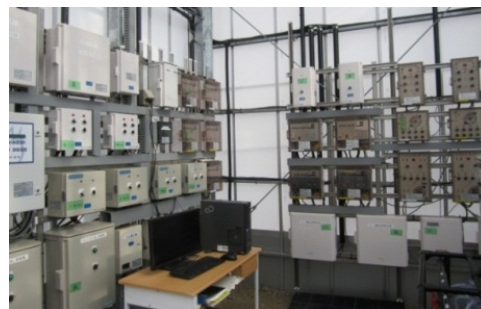
換気・冷暖房・肥料・CO 2 等を コントロールする制御装置
