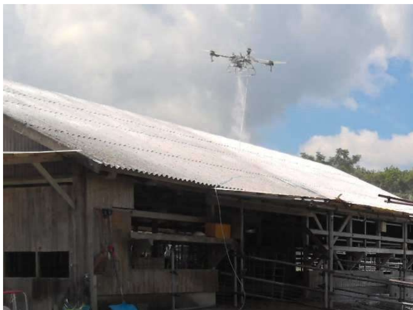
消石灰をドローンで吹き付ける作業 (R7.9.5施工)
