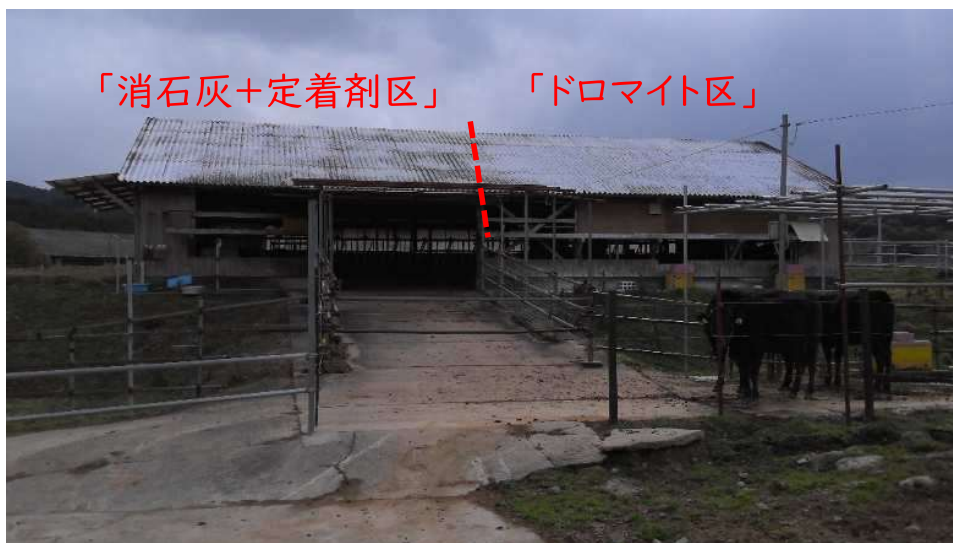
写真：施工して4か月後の屋根の様子 向かって右側が「ドロマイト」塗布 向かって左側が「消石灰+定着剤」塗布
