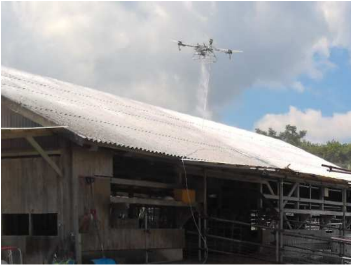
消石灰をドローンで吹き付ける作業 ＝㈱日本環境テクノ(佐賀市)が実施
