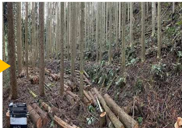
整備後（富士地区）
