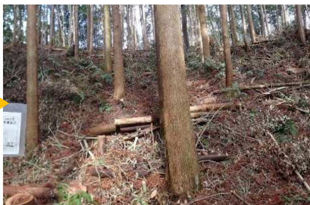
整備後（唐津地区）
