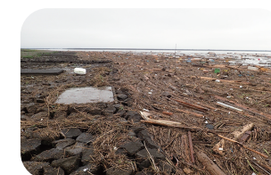
下流域での被害
