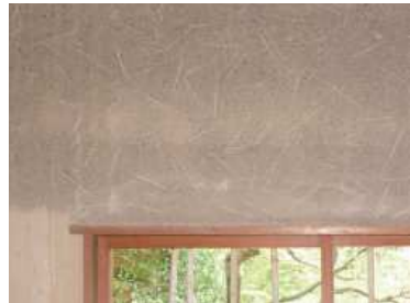
図 6-2-47 壁土の中塗仕上げ
