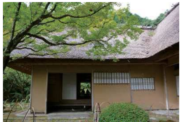
図3-4-9 A 表玄関 【イ）主屋・主屋南地区】
