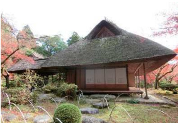
図3-4-8 A 客間棟 【イ）主屋・主屋南地区】
