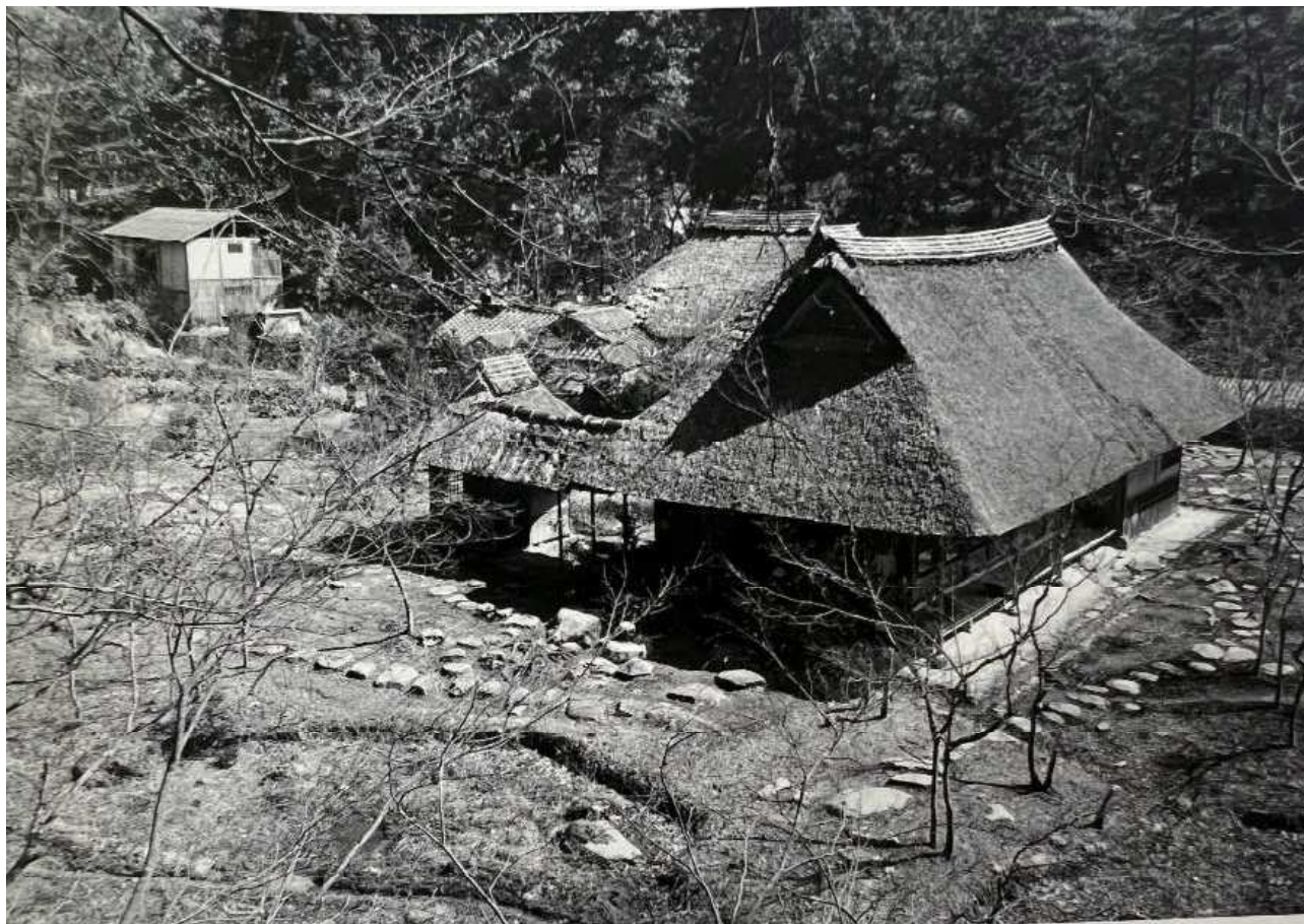
図3-1-1 かつての建物全景（昭和35年（1960）頃撮影、奈良文化財研究所所蔵）
