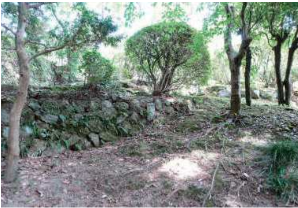
図3-4-2 A 石垣 【ア）山林地区】
