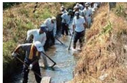
水路の泥上げ
