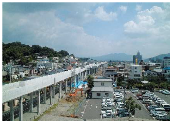
●JR佐世保線武雄温泉駅付近連続立体交差事業(武雄市)
