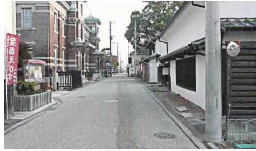
●区画街路 町家通り線(佐賀市)
