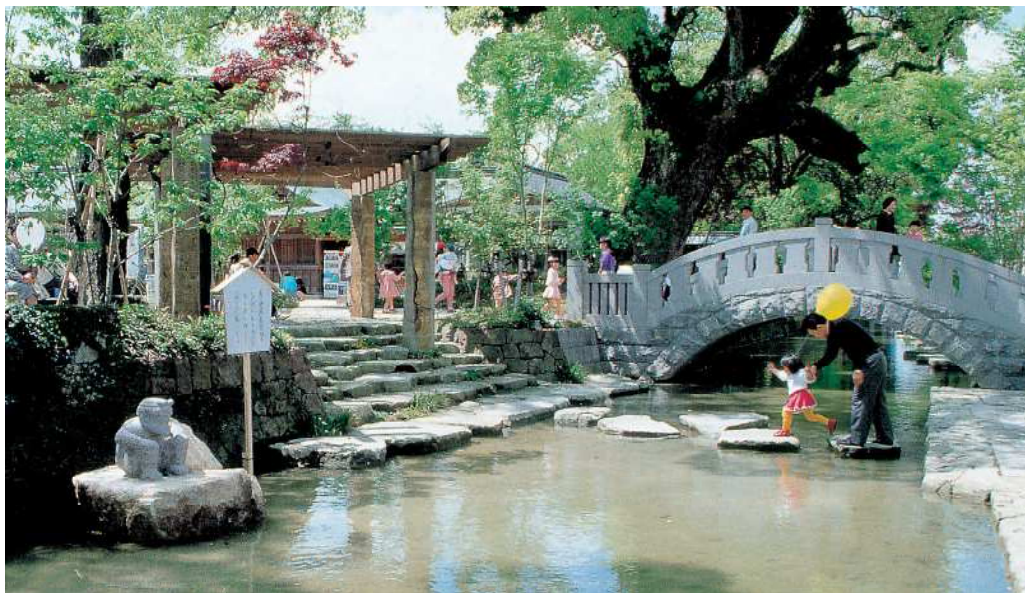
●新世代下水道支援事業(旧水循環・再生下水道モデル事業)で整備した田代第4雨水幹線(佐賀市松原川) 緑豊かな水辺環境の整備により、市民の憩いの場となりました。
