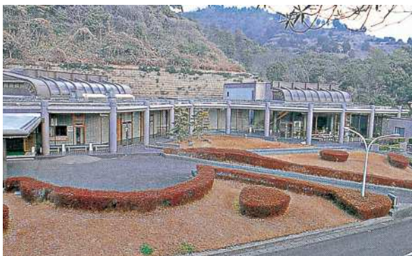
●火葬場(佐賀市つくし斎場)
