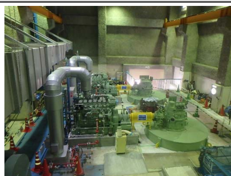
河川氾濫時の内水を排水する設備
