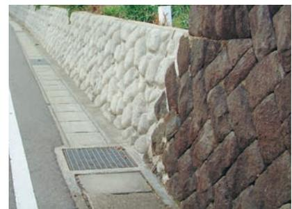
石の形態を模した型枠によるコンクリート擁壁が、伝統的な石垣(手前)と調和していない。
