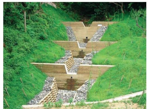
残置式小径丸太型枠で県産木材を使用し、周囲を緑化することで、自然景観と調和している。(武雄市)
