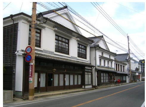
伝統的建造物群保存地区（有田町）
