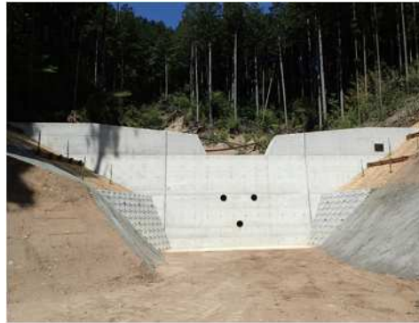
工事完了（溪間工事）
