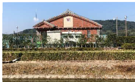
農業集落排水処理場
