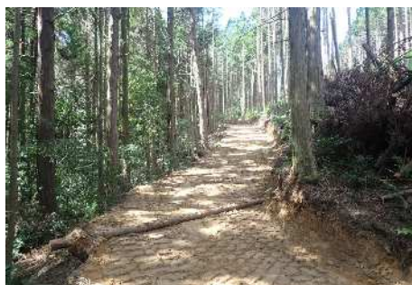
森林作業道の作設
