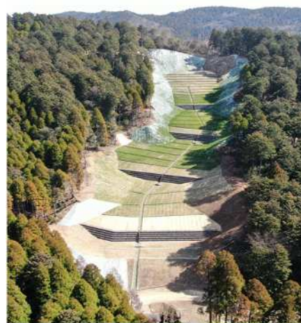
工事完了（山腹工事）
