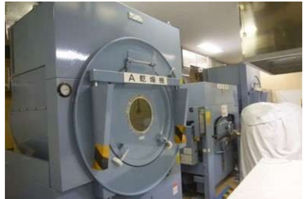
【洗濯設備※ 2 解体撤去作業状況】
