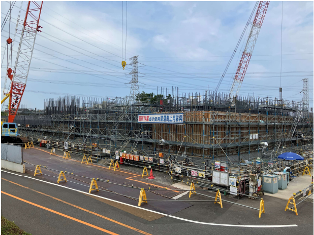
工事状況 (建屋設置工事)
