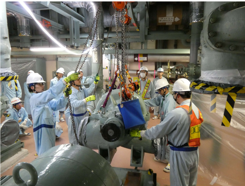
【原子炉補機冷却水ポンプ※ 1 解体撤去作業状況】
