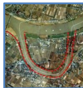
写真 1.3 坂口捷水路 (出典:筑後川河川事務所HP)
