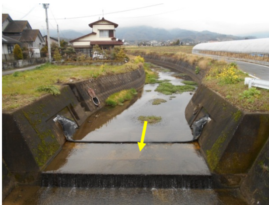
写真 5.3 西光寺川 田手川合流点から上流を望む
