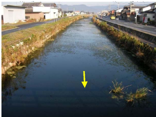
写真 5.4 荒堅目橋から上流を望む
