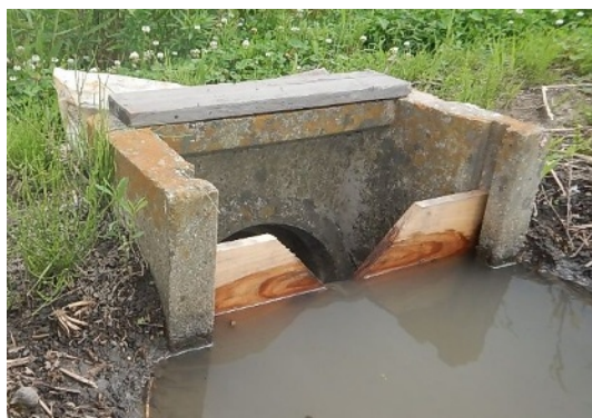
田んぼダムの調整板の設置
