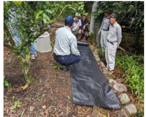
防草シートの設置
