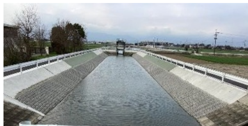
大詫間幹線水路における法面对策
