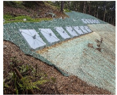
抑止杭工により安定化された斜面（武雄市）
