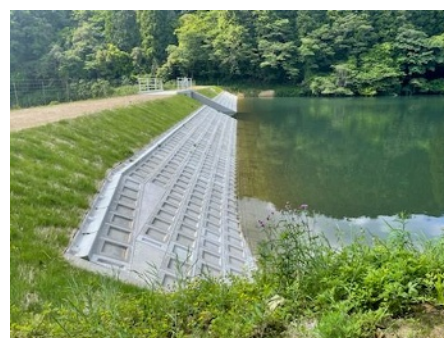
補修工事されたため池 （武雄市）
