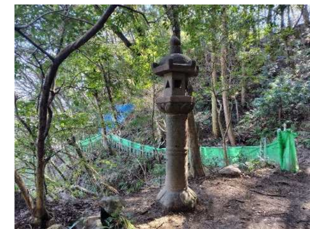
石造物修理 2 山林苑路灯籠（完了：北より）
