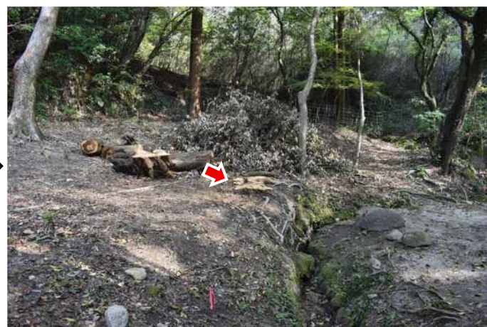
樹木伐採④ 山林平場（完了：東より）
