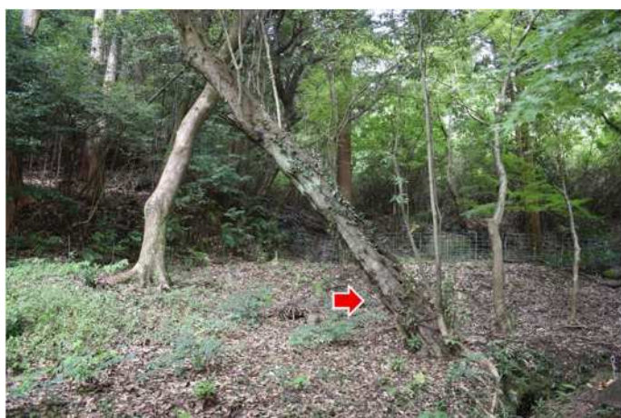
樹木伐採④ 山林平場（着手前：東より）
