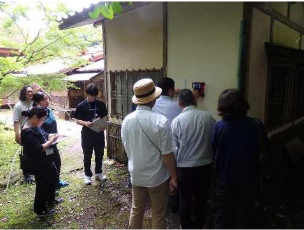
ボイラー棟 鉄筋探査調査の様子▶
