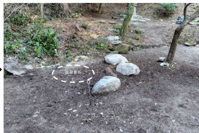
抜根対象箇所④（幹周 90 以上 120 未満） 〔山林平場・層塔南 完了：東より〕
