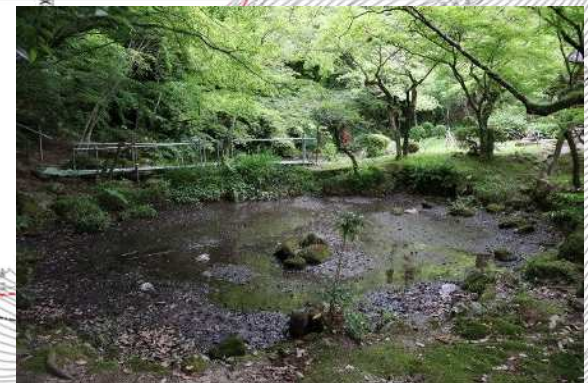
堆積土撤去 園池下段（南から）
