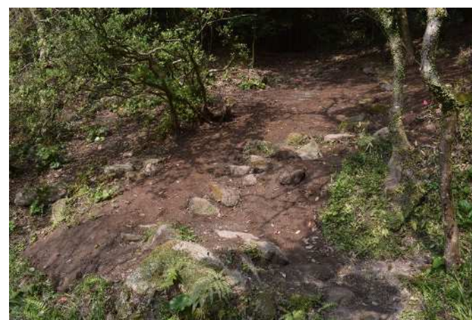
法面修理（暗渠排水工含む）、伐採①・抜根①対象地 〔山林平場法面 苑路3〕（完了：東より）
