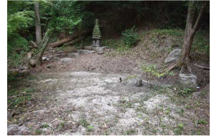
土砂撤去対象箇所（山林平場内流土） （着手前：東より）
