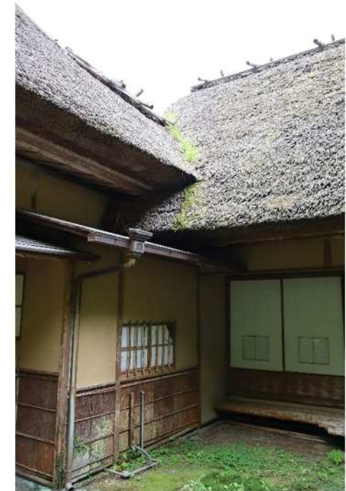
補修箇所② 客間棟北側（西から見る）
