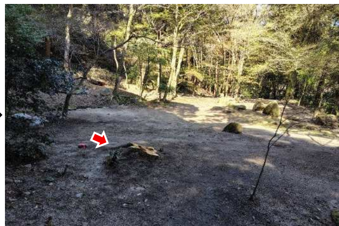
樹木伐採③ 山林平場（完了：南より）
