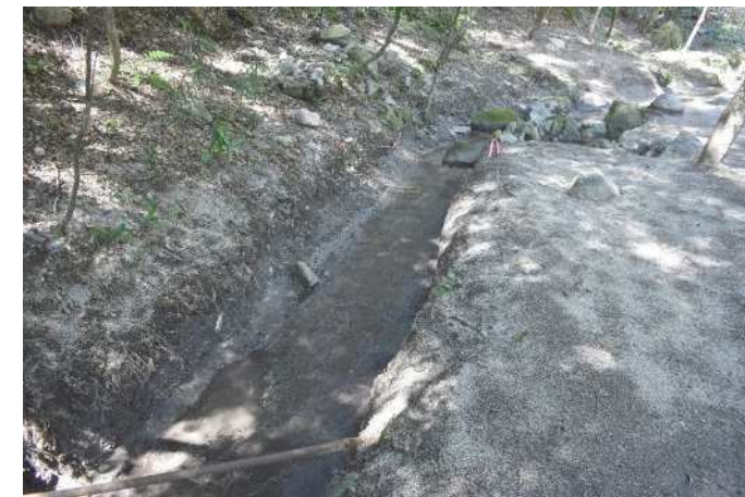
土砂撤去対象箇所〔山林平場水路〕（完了：南より）
