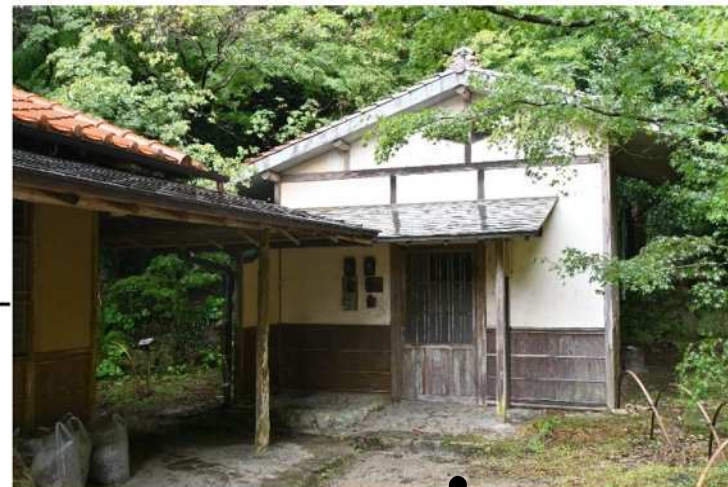
ボイラー棟（南から見る）
