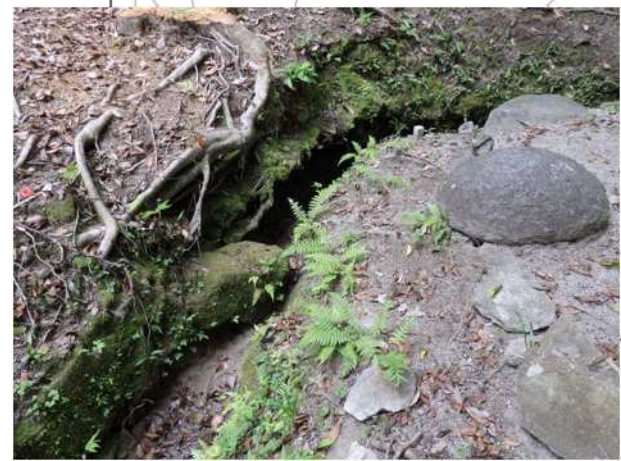
水路護岸修理 対象箇所詳細 (南東から)
