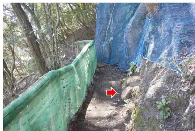
樹木伐採② 山林部苑路（完了：北より）
