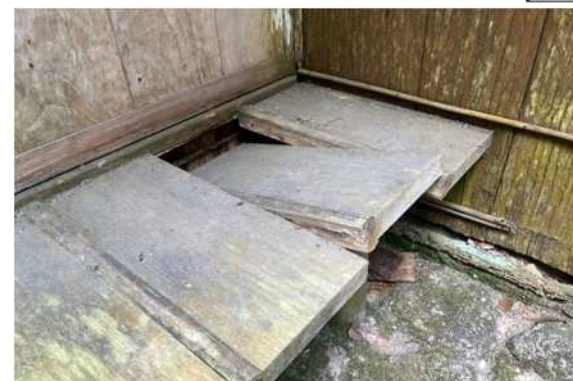
居間棟北側縁（縁板補修対象箇所）
