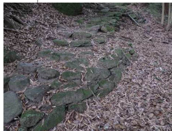
苑路石段補修 対象箇所詳細② (南東から)
