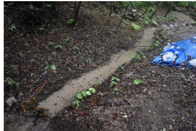
土砂撤去対象箇所〔山林平場水路〕（着手前：南より）
