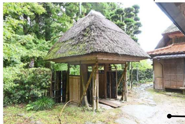
東門（北から見る）
