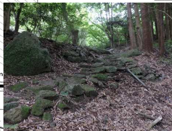
苑路石段補修 対象箇所① (南東から)
