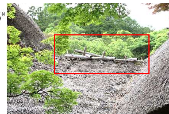
客間棟東側渡り廊下屋根（東から見る）
