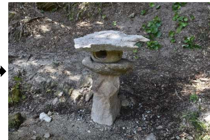
石造物修理3 下段庭園 山灯籠（完了：東より）
