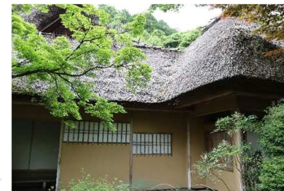
補修箇所③ 客間棟東側（東から見る）
