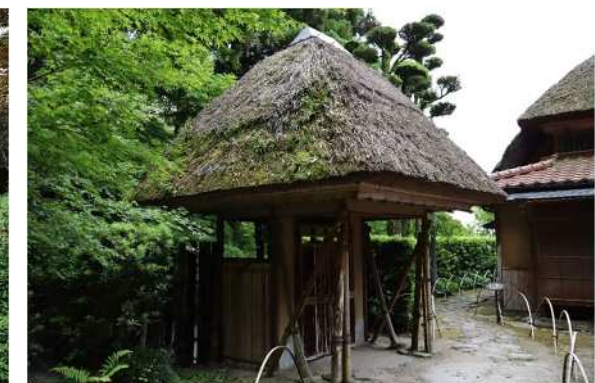
補修箇所④ 東門（北から見る）
