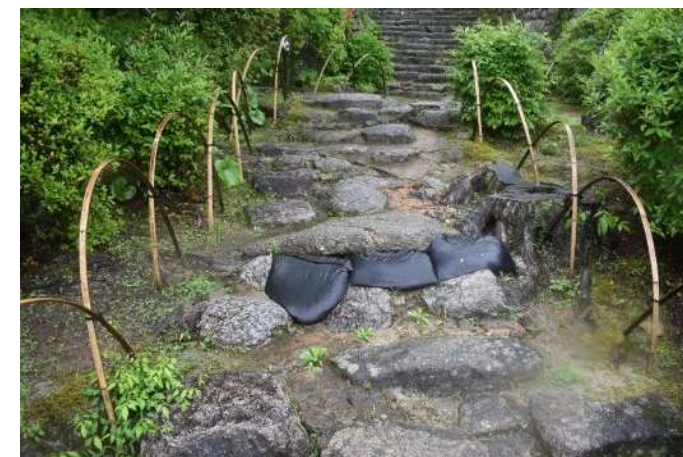
苑路石段修理、抜根②対象箇所〔下段庭園苑路〕 （着手前：南より）
