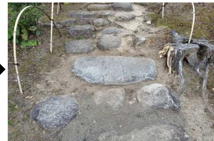
苑路石段修理、抜根②対象箇所〔下段庭園苑路〕 （完了：南より）
