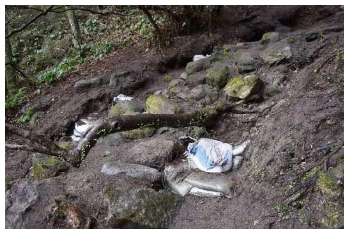
法面修理（暗渠排水工含む）、伐採①・抜根①対象箇所 〔山林平場法面 苑路3〕（着手前：東より）
