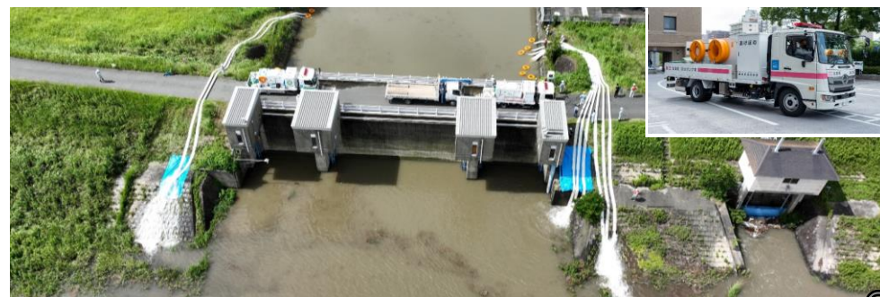
R5.7 排水ポンプ車の出動
