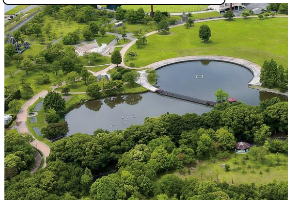
森林公園 水質浄化設備の改修
