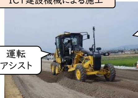
ICT建設機械による施工
