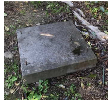
図3 撤去対象のコンクリート
