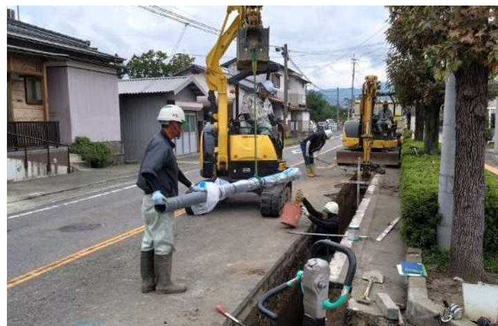
老朽管から耐震管（ダグタイプル铸铁管）への更新
