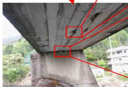
非常用洪水吐管理橋梁
