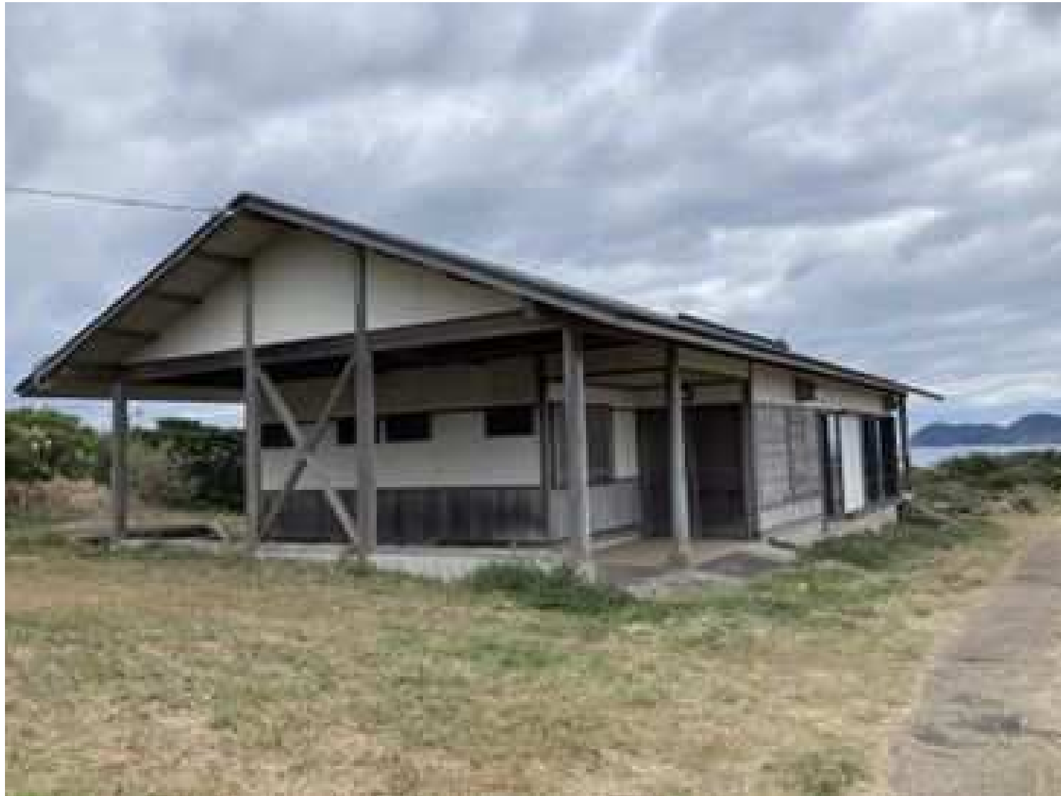
玄海国定公園加部島地区 野営場避難棟 ※野営場廃止後の残存施設
