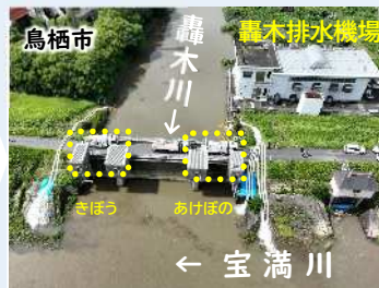
▶ 排水ポンプ車の活用
