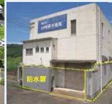
▶ 排水機場機能向上
