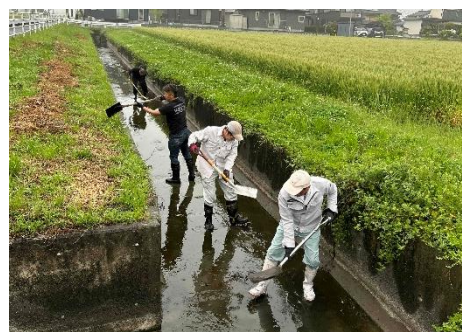
【水路内の泥上げ】
