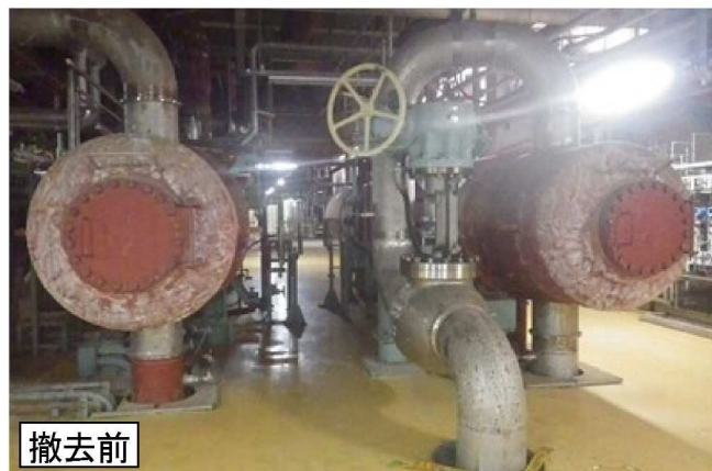
第3低压給水加熱器
