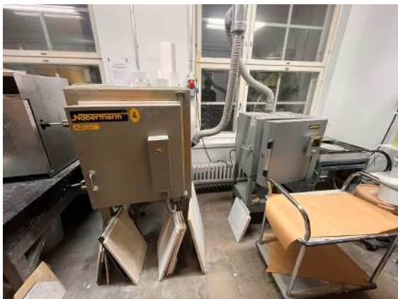
電気炉などの設備
