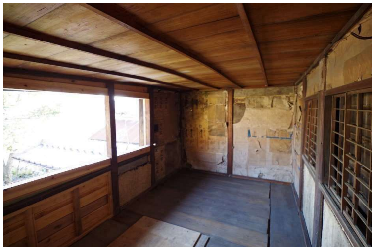
2階月見部屋 内部（北西より見る）
