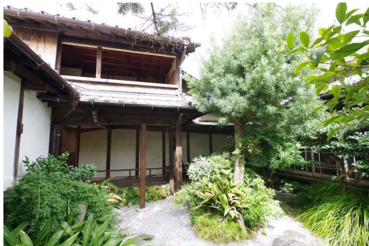
便所兼月見部屋 東面外観
